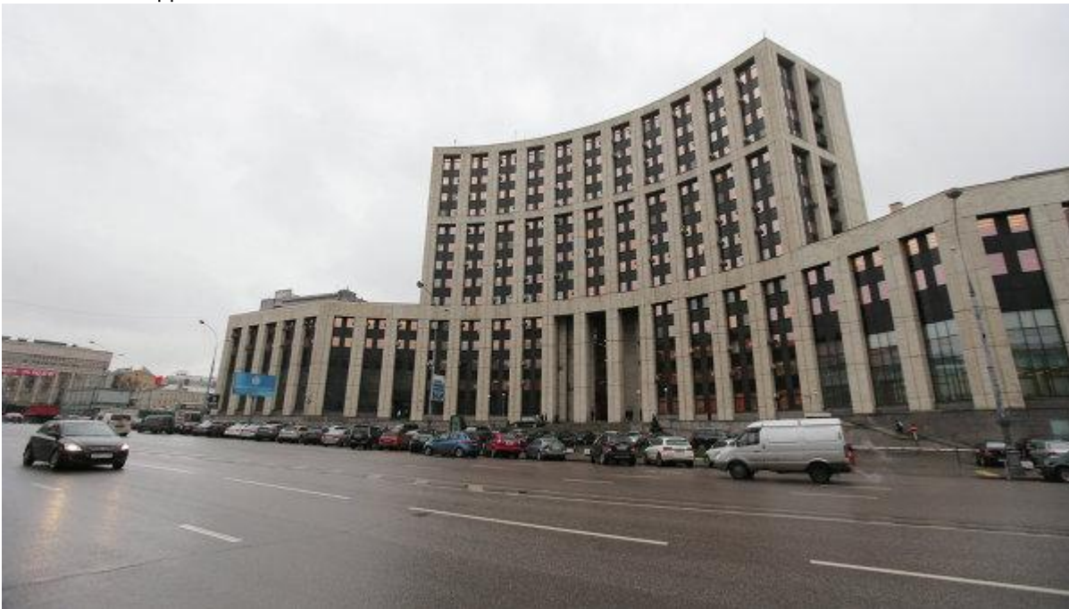
Здание Внешэкономбанка РФ. Архивное фото
